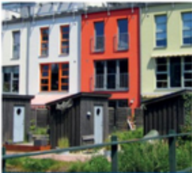
Ein hoher Wasserverbrauch verursacht gleich zweimal Kosten – einmal für Frischwasser und einmal für Abwasser.
